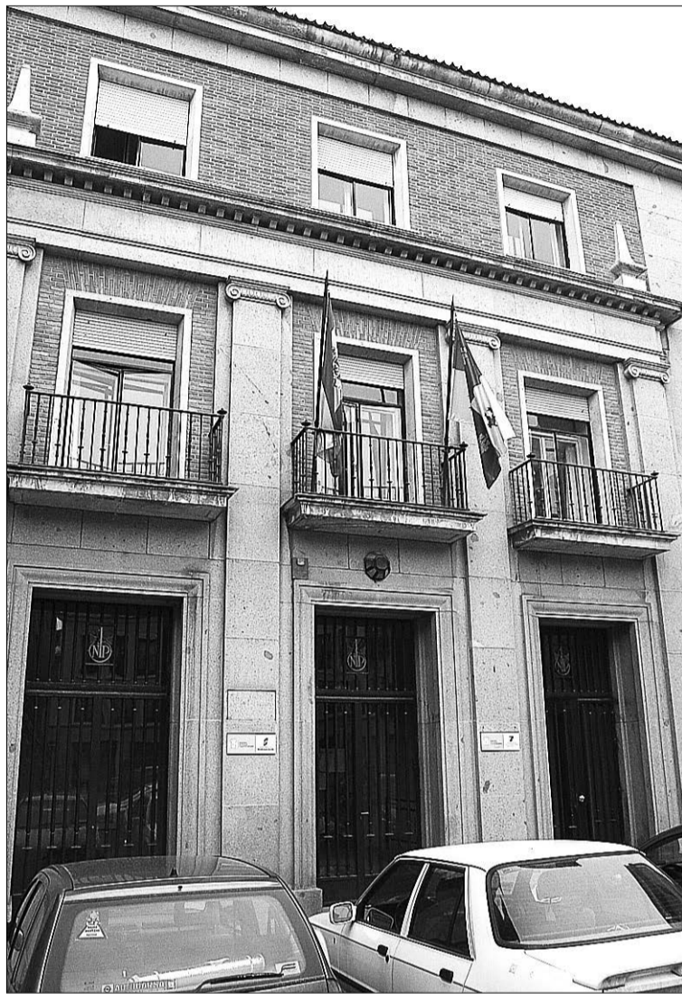
Imagen de la fachada principal del edificio del INSS. / KAMARERO
