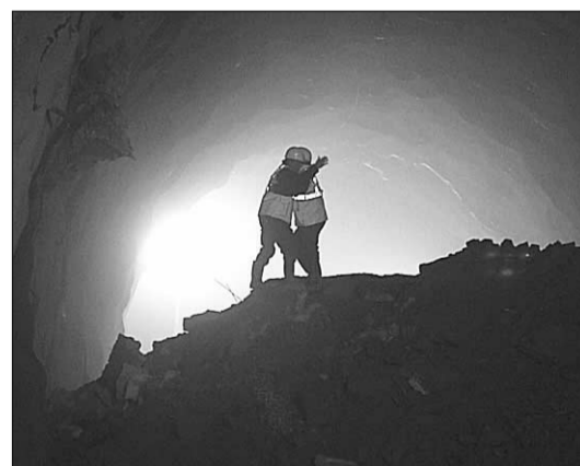
Los operarios de ambos lados se abrazan tras el cale.
