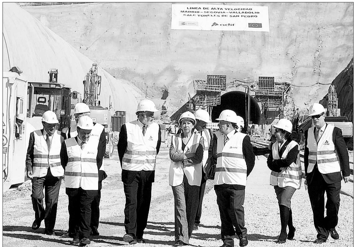
Las autoridades, con la ministra en el centro, asistieron al cale del túnel este del Cerro de San Pedro. / EL ADELANTADO
