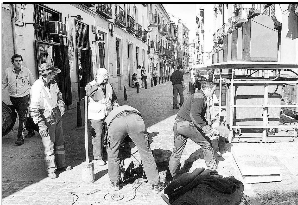
Corte de tráfico en Infanta Isabel. La calle Infanta Isabel quedó ayer cerrada al tráfico durante buena parte de la mañana para permitir la ejecución de diversas obras de mejora de su firme. En concreto, la tarea consistió en la recolocación de losas de granito sueltas del pavimento de la calle. / FOTO: KAMARERO
