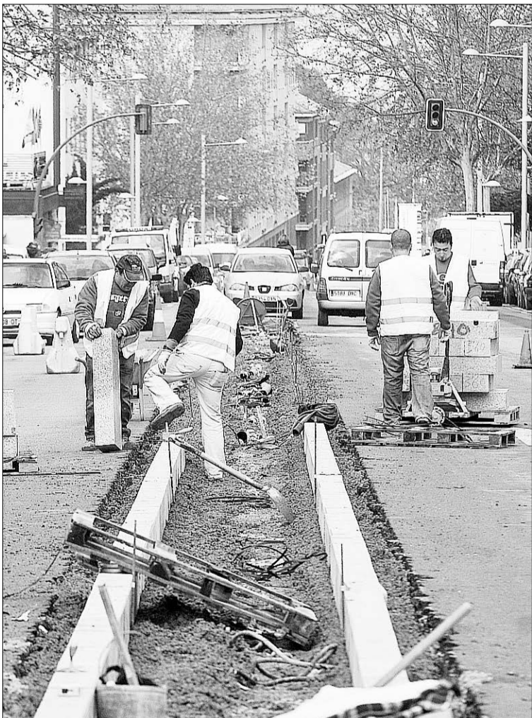
El Ayuntamiento sancionó a la empresa que arregla las travesías. / JUAN MARTÍN
