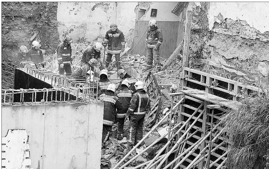
Varios bomberos inspeccionan las ruinas de la casa hundida, justo al lado de los andamios de unas obras colindantes. / EFE
