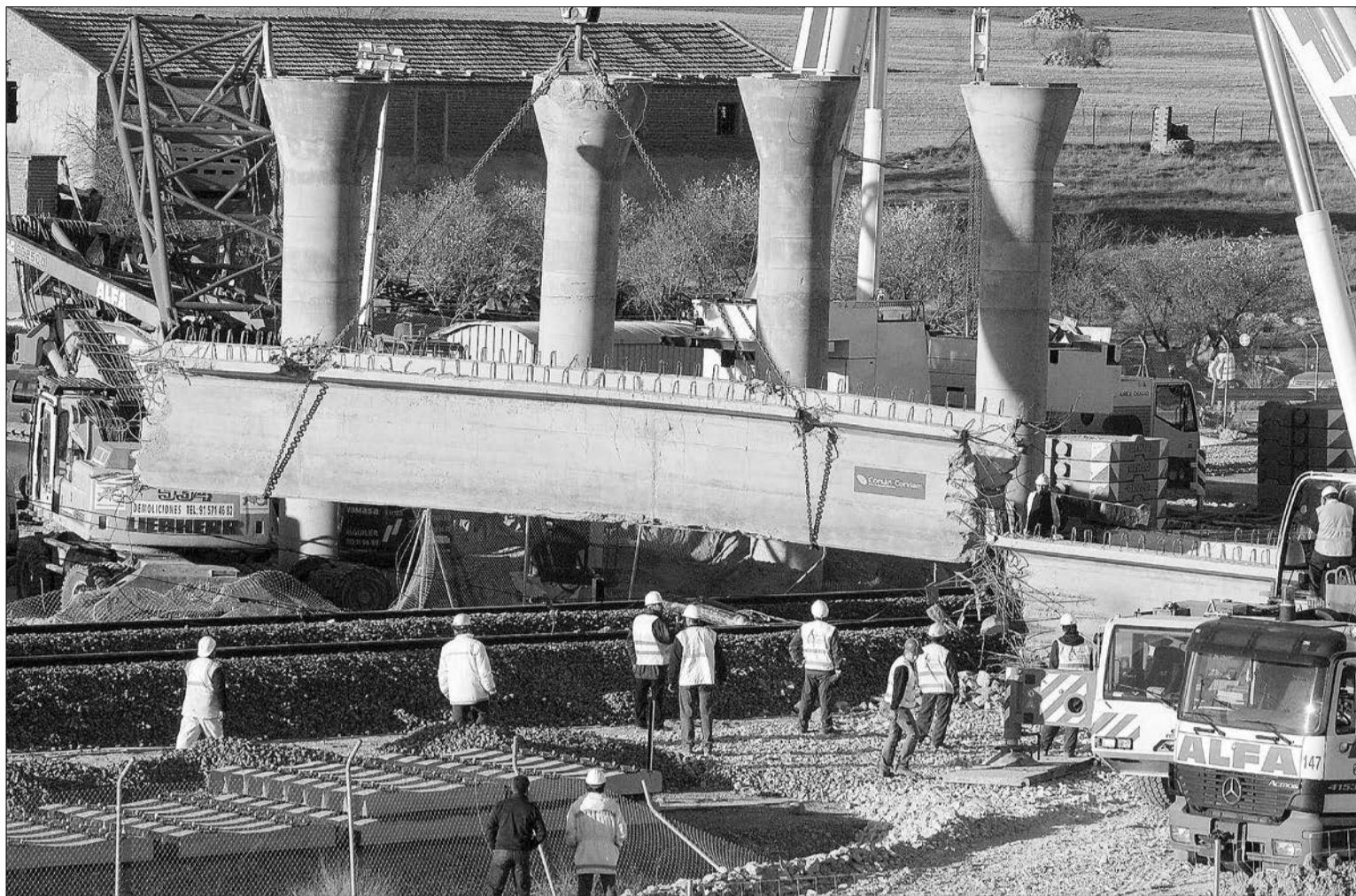
Decenas de operarios se afanaron durante toda la jornada para retirar la estructura que bloqueaba las vías del AVE y lograron despejar el trayecto a media tarde. / EFE
