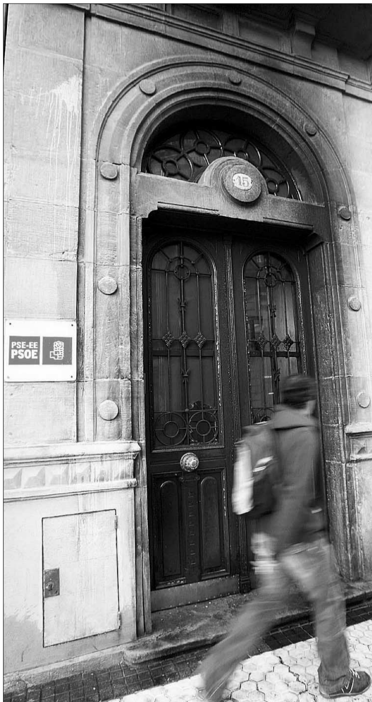
Un transeúnte observa la fachada ennegrecida de la sede del PSE en San Sebastián. / EFE
