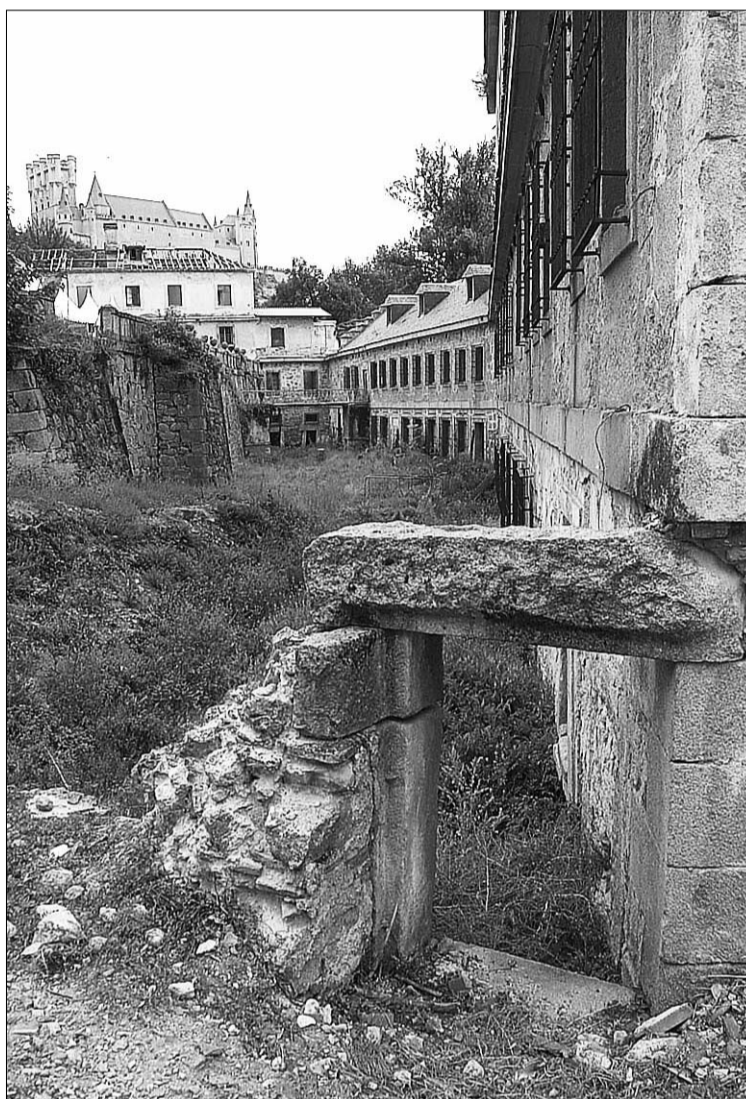
El progresivo deterioro de la Ceca llegará ahora a su fin. / JUAN MARTÍN
