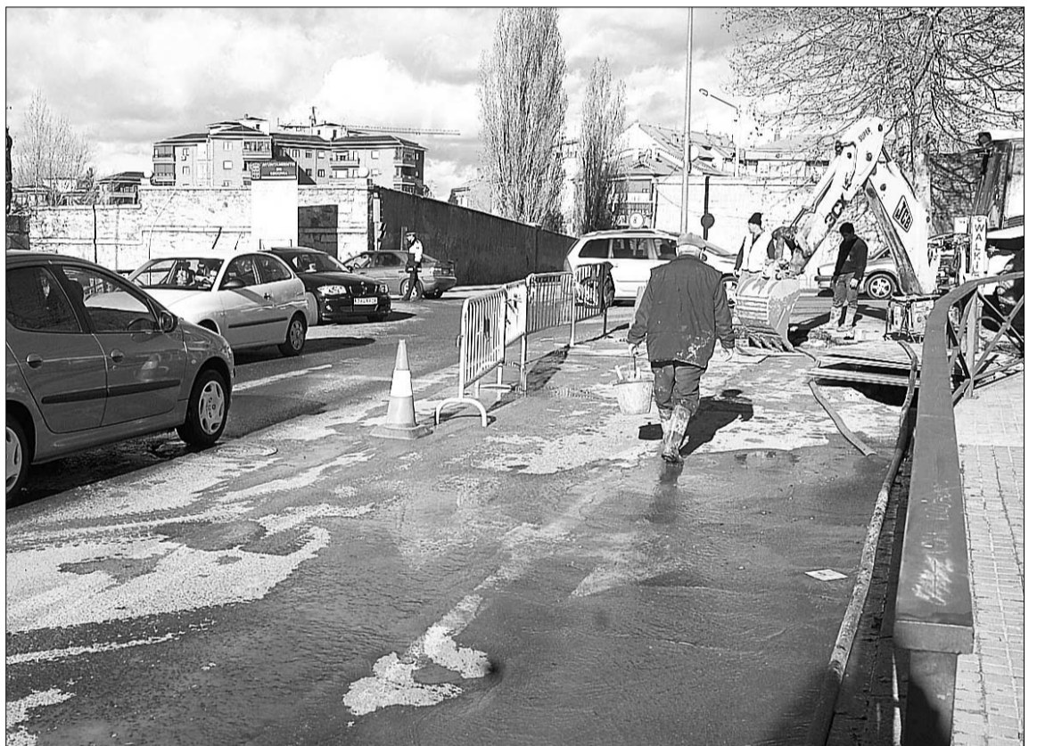
Los trabajos están estrechando la calle Coronel Rexach, aunque la vía permanece abierta al tráfico. / JUAN MARTÍN
