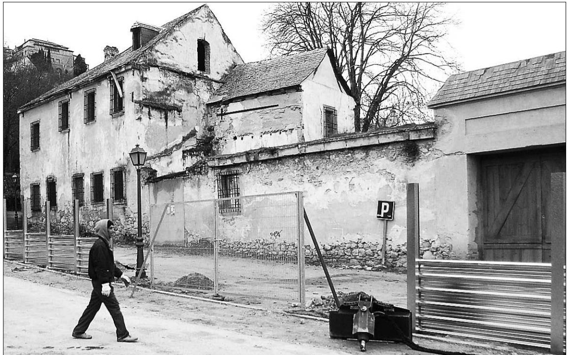
Las obras de rehabilitación del inmueble tienen un plazo de ejecución de 25 meses./KAMARERO
