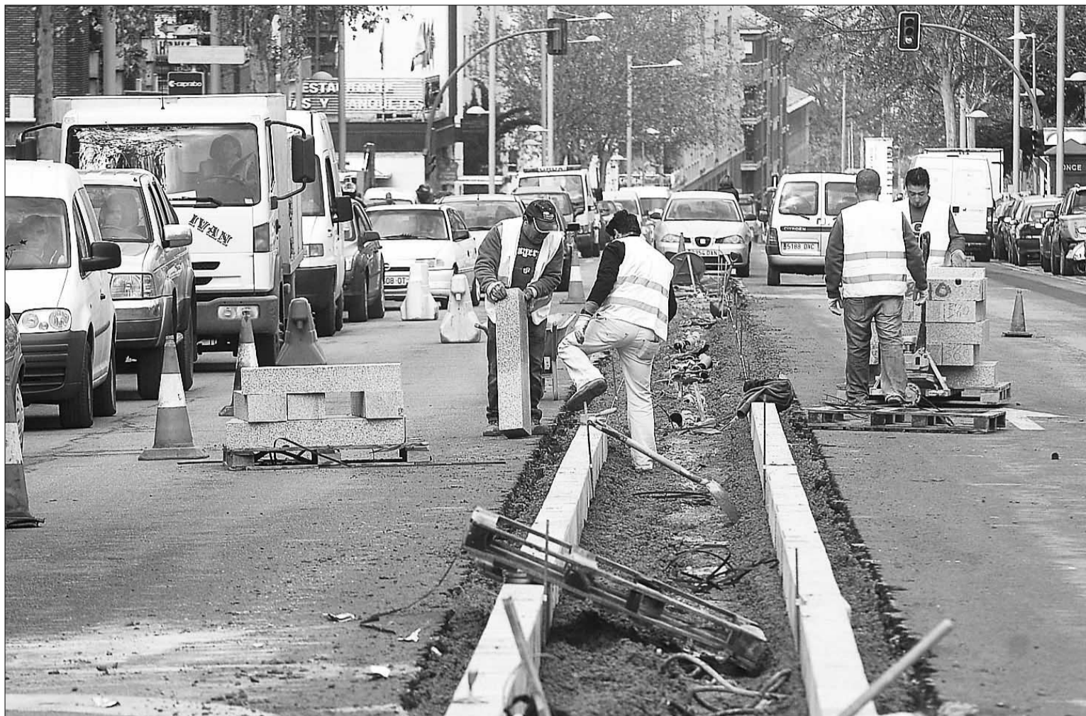
Los trabajos en el Paseo Nuevo avanzan con la colocación de bordillos en las medianas y de las baldosas en las aceras/KAMARERO
