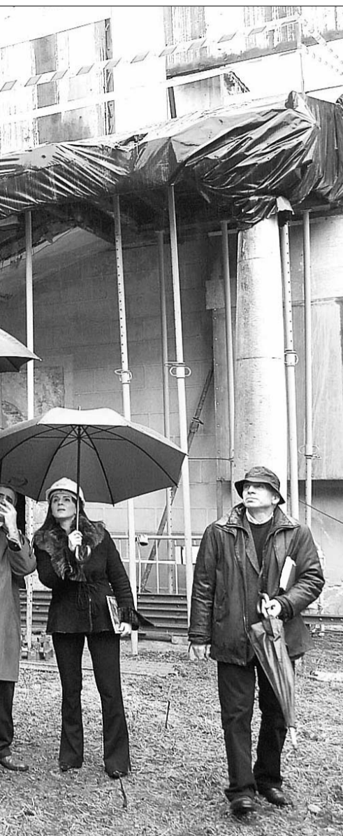
Obras de consolidación/JUAN MARTÍN
