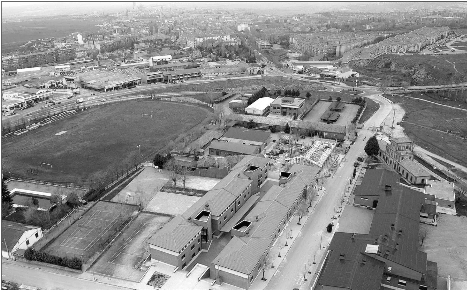
Imagen del entorno del acuartelamiento de Baterías. La ampliación de las instalaciones está prevista en el desarrollo del sector Prado Bonal./A.M.
