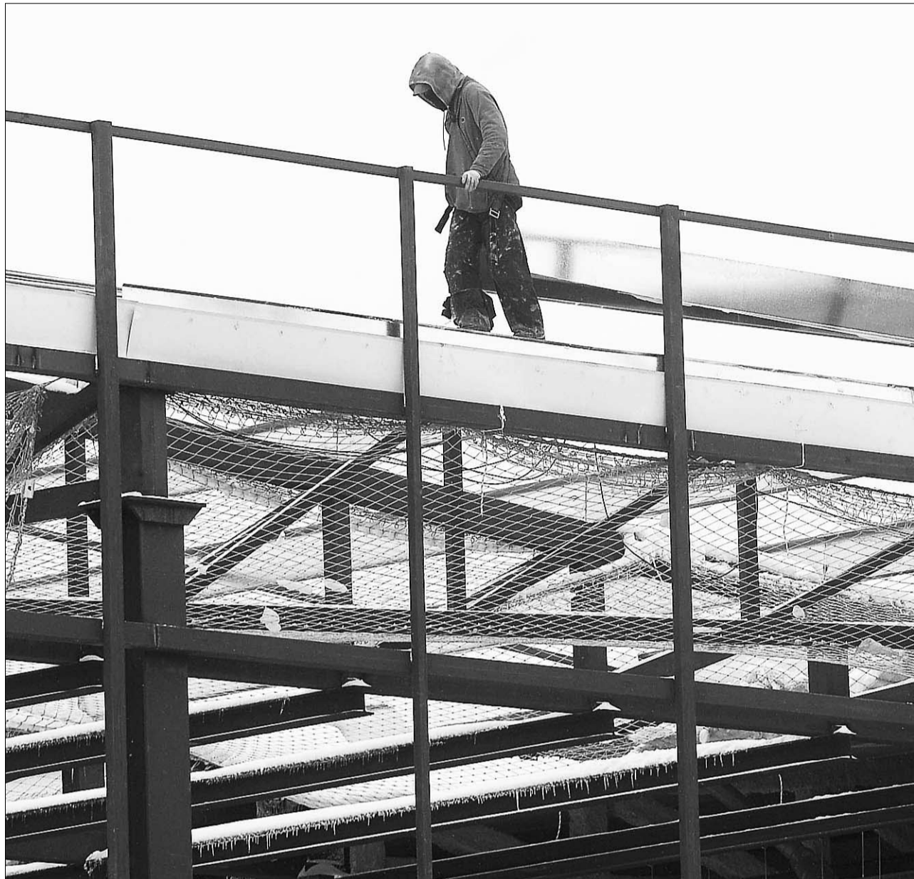
El Observatorio Socio Económico de Segovia prevé que se reducirá la construcción de viviendas, aunque el sector tendrá en la provincia el i
