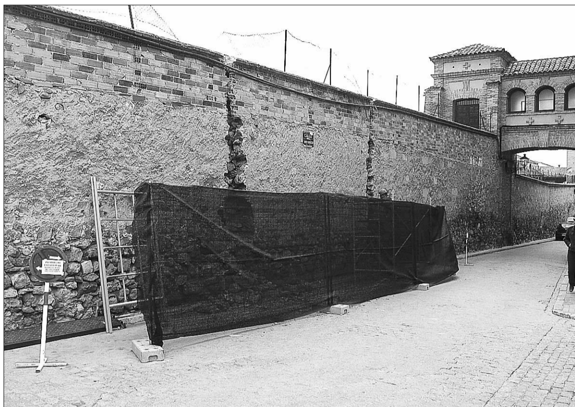
En abril del 2005, el Ayuntamiento inició la ocupación del patio del Seminario para acometer las obras del Cervantes/A.K.
