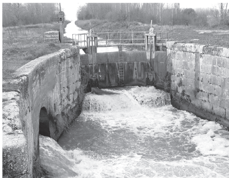
Se realizan inversiones para restaurar esclusas, fábricas y molinos
