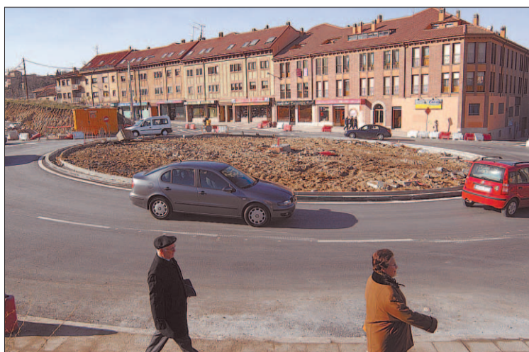
Nueva rotonda construida en la avenida de Vía Roma/JUAN MARTÍN
