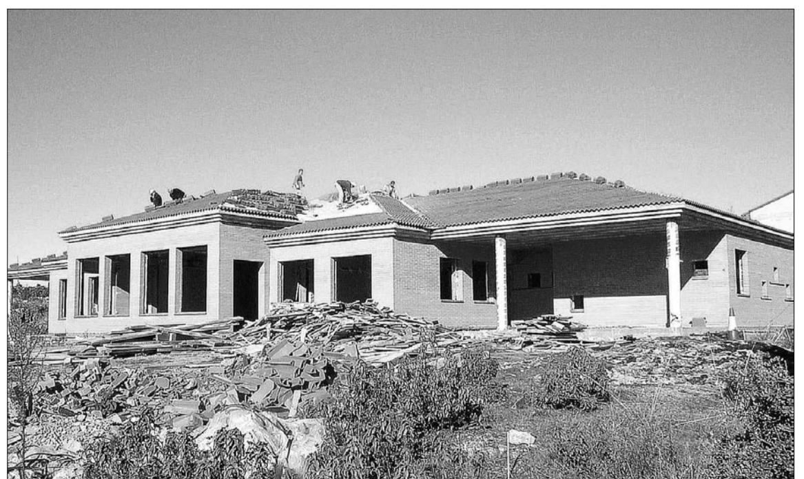
Imagen de las obras del nuevo colegio tomadas hace varias semanas, situado junto a la carretera de Otero. /ÁLVARO PINELA
