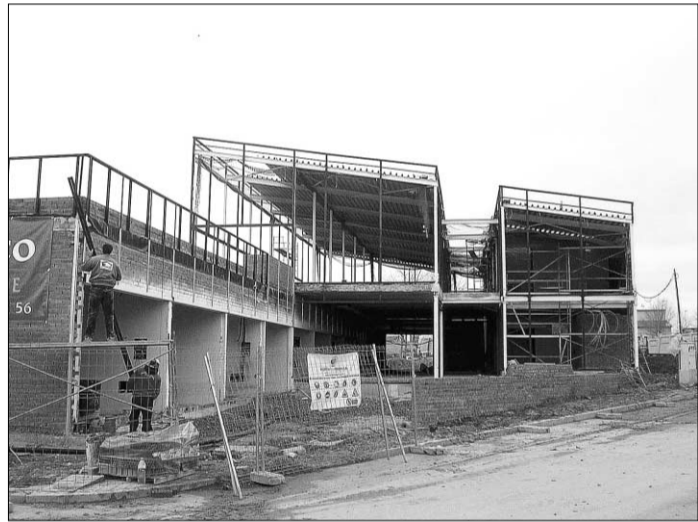
Los trabajos del centro comercial siguen su curso. /ÁLVARO PINELA
