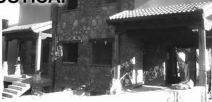
Estructura de madera de 1ª calidad (pino de Valsain) (Pilares forjados, vigas, porches,...)
