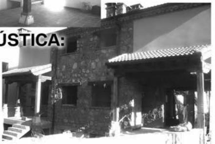
Estructura de madera de 1ª calidad (pino de Valsain) (Pilares forjados, vigas, porches,...)
