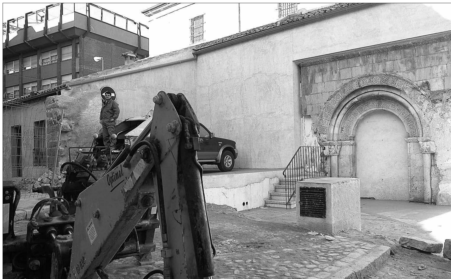
Las obras harán posible que el popular barrio segoviano cuente con un nuevo espacio en torno a la recién descubierta portada románica. // JUAN MARTÍN
