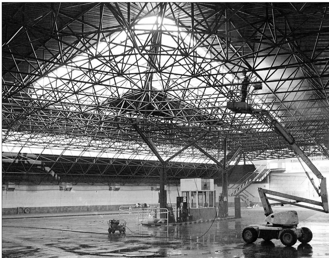
Obras de remodelación en la Estación de Autobuses de Burgos. / IGOR GONZALO
