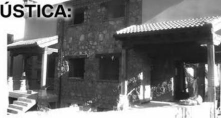
Estructura de madera de 1ª calidad (pino de Valsain) (Pilares forjados, vigas, porches,...)
