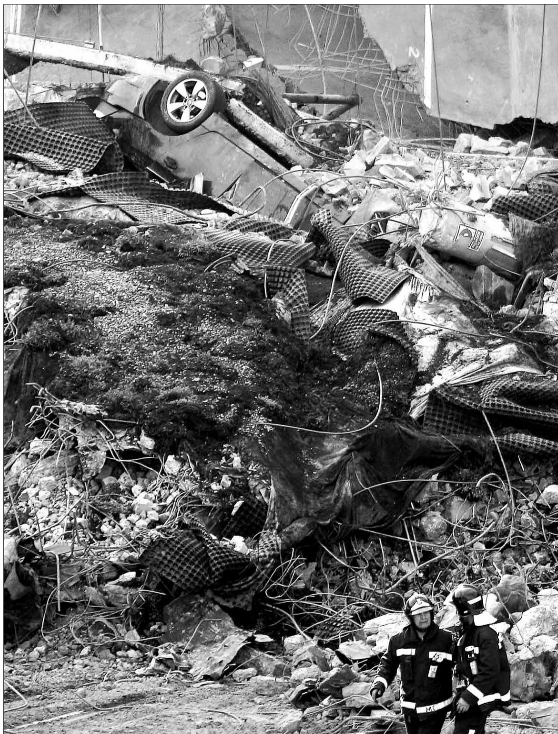
Pese a que el desescombro dura ya una semana, la devastación que causó la bomba sigue siendo evidente. / EFE
