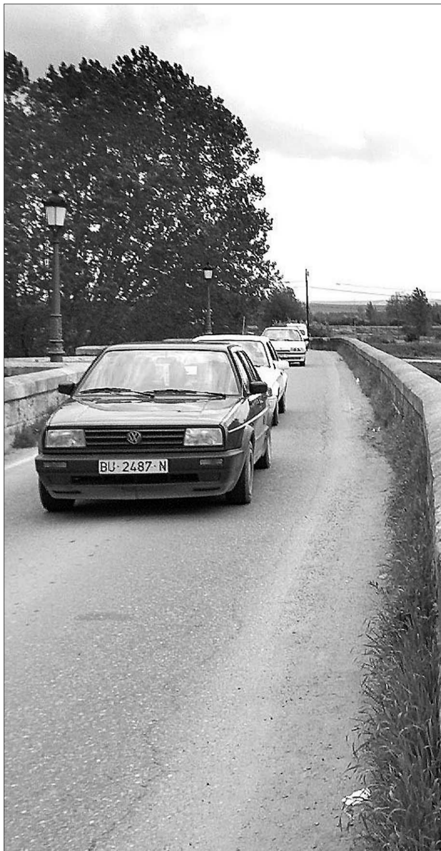
La Junta actuó en la mejora del puente sobre el Río Carrión en Villamuriel del Cerrato. / ICAL
