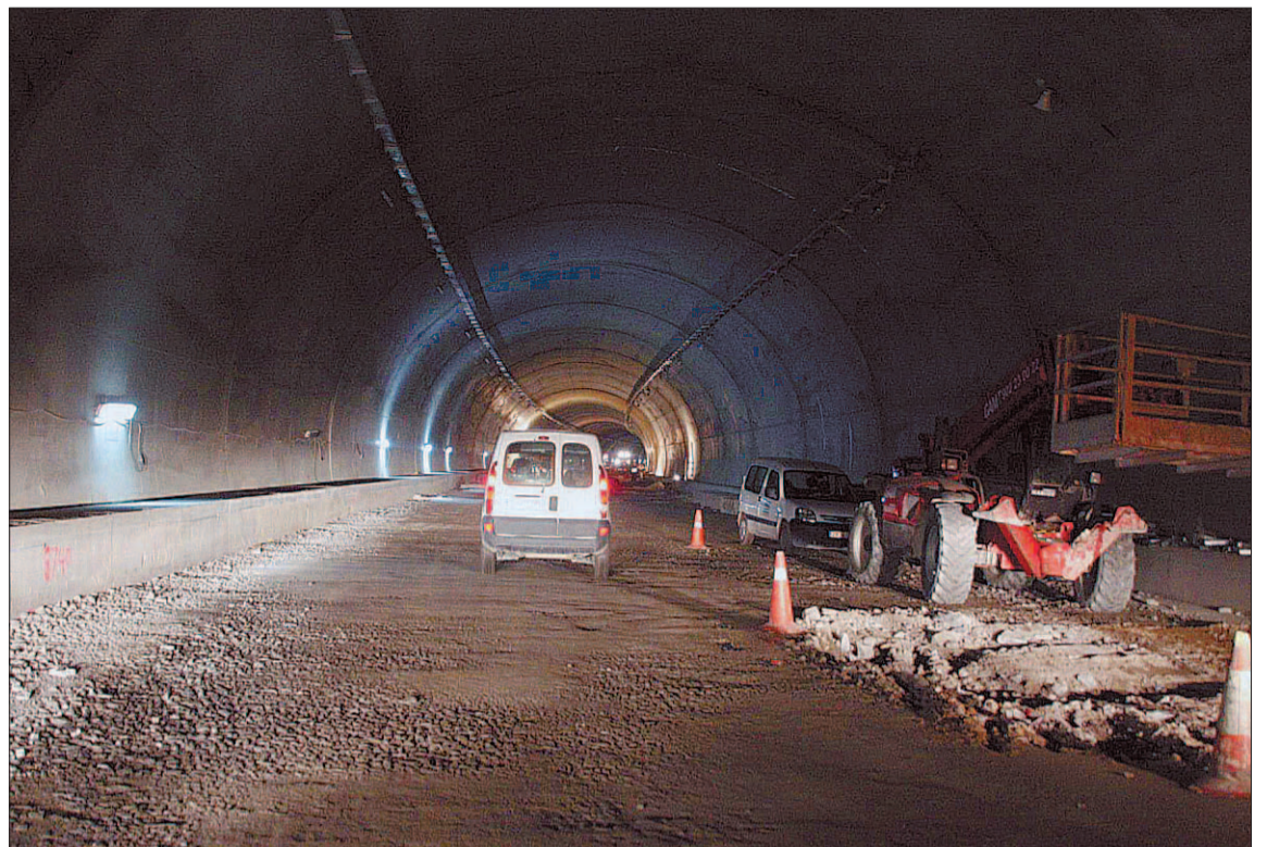
Las obras de los túneles cumplen los plazos previstos para concluir su construcción./PEÑALOSA
