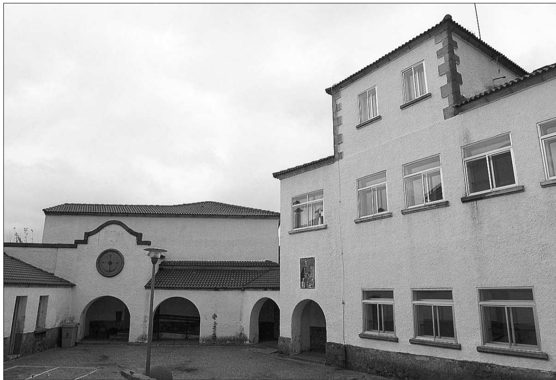
Estado actual de las instalaciones del colegio Arcipreste de Hita de El Espinar. / PEDRO L. MERINO
