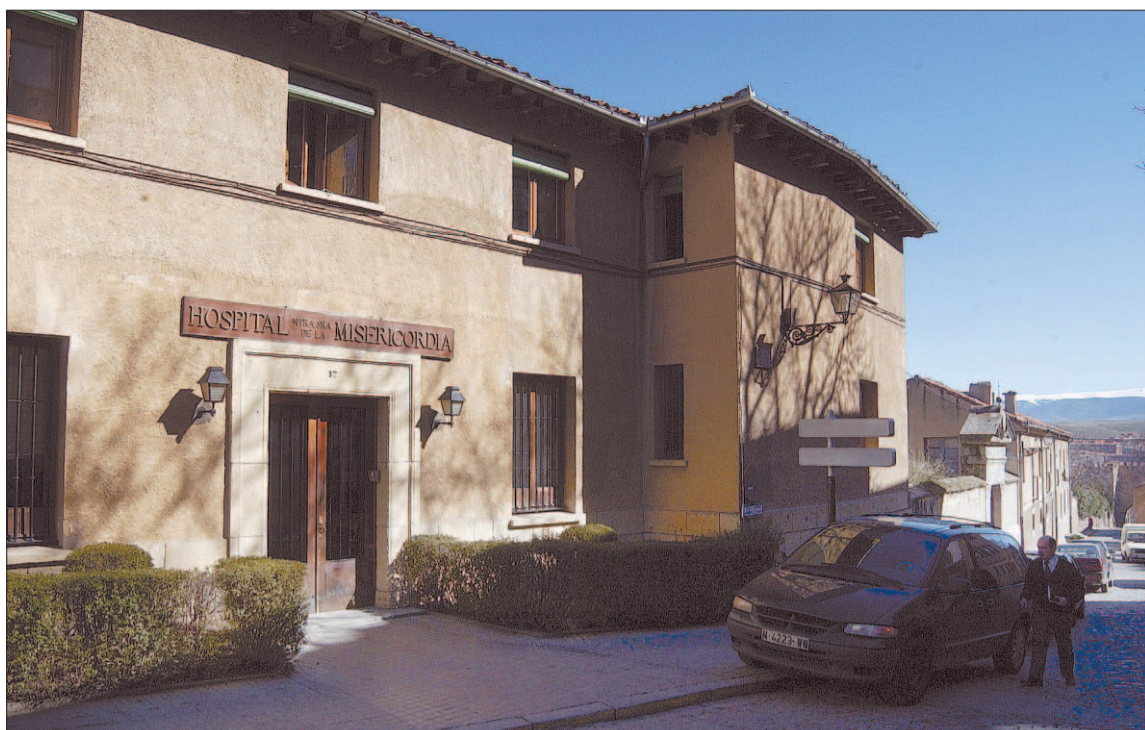
Hasta final de año el Hospital de la Misericordia seguirá realizando operaciones derivadas del Hospital General. /JUAN MARTIN
