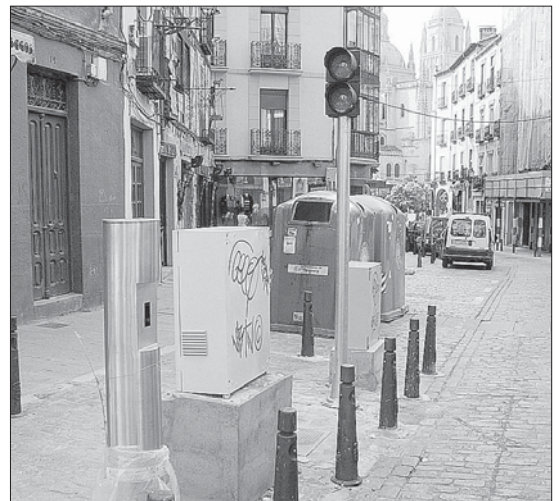
Sistema instalado en la calle Cronista Lecea / JUAN MARTÍN
