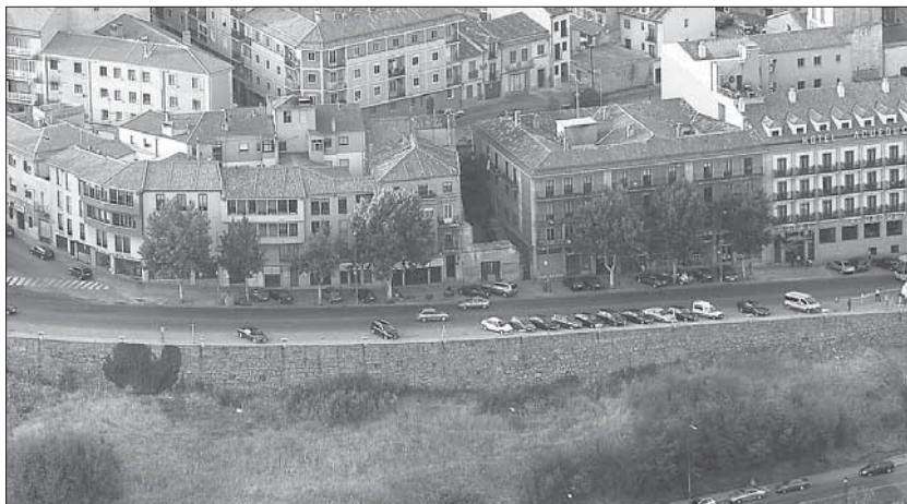
Los terrenos en terraplén entre las avenidas Padre Claret y Vía Roma no son de propiedad municipal/JUAN MARTÍN
