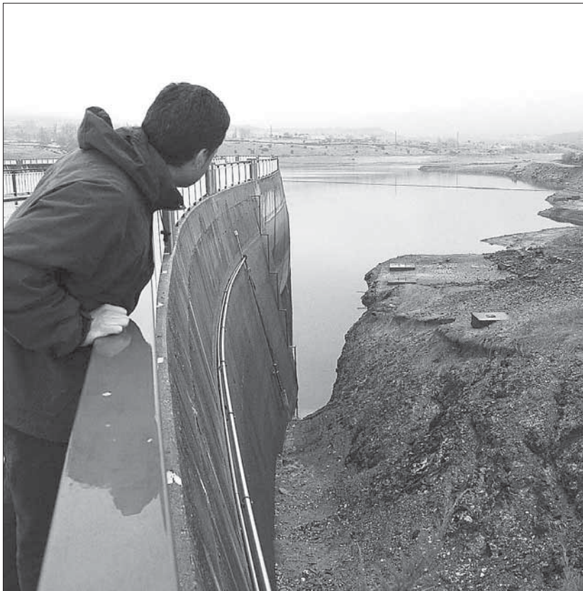
La planta de El Maderuelo capta agua del Pontón Alto antes de distribuirla a los municipios de La Atalaya. /JUAN MARTÍN
