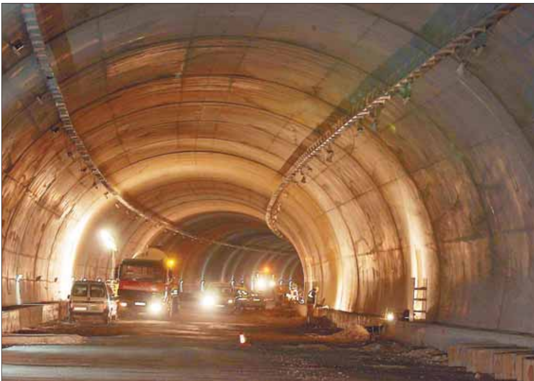
Las obras del tercer túnel que horada la sierra de Guadarrama se encuentran en una fase muy avanzada de construcción / PEDRO MERINO
