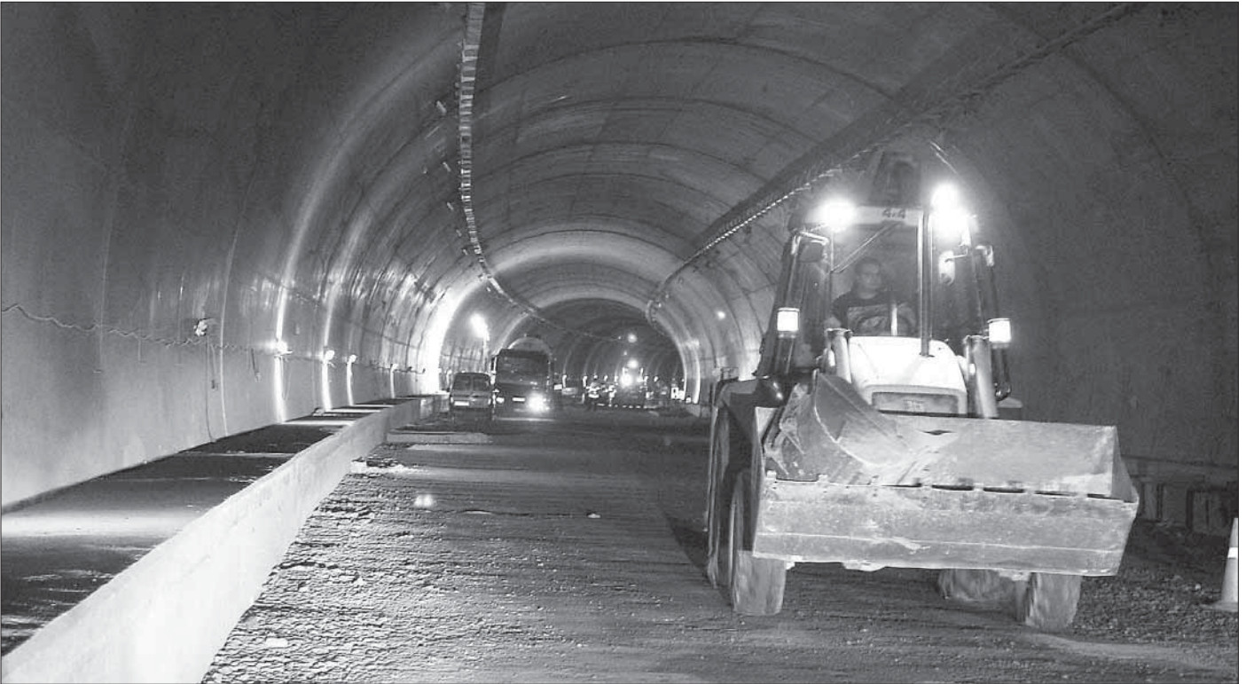
El tercer túnel de Guadarrama de la AP-6 tendrá una longitud algo superior a los tres kilómetros y contará con tres carriles en dirección a Madrid. / PEDRO L. MERINO
