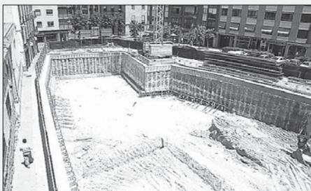
• **Magnitud de las obras.** La excavación que precisaba la infraestructura alcanzó los 12 metros de profundidad.
