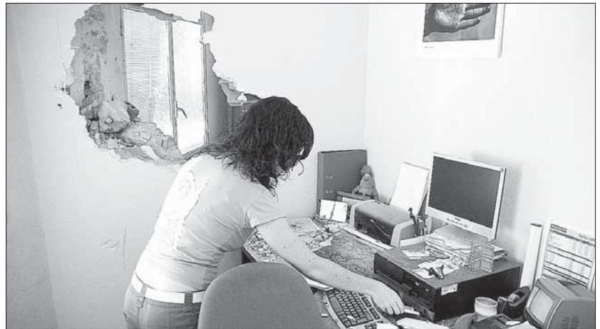
Los ladrones emplearon fuertes mazas para destrozarse los muros donde se encontraba una caja fuerte. / KAMARERO
