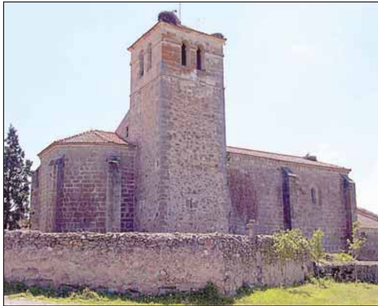
Fotografía de la iglesia de San Juan Bautista de La Losa / FÉLIX BLANCO
