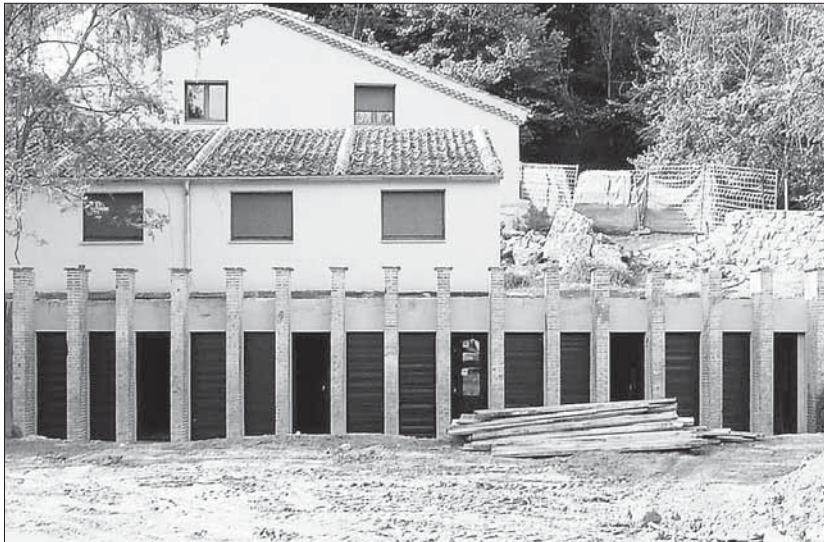
Uno de los muros de contención que albergan los miniapartamentos. Se han construido 16, aunque se proyectaban 46/A.S.
