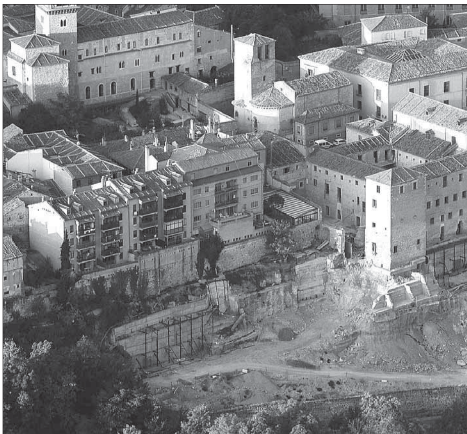
Tras varios meses de paralización y una intensa polémica, la propiedad del antiguo convento de las Oblatas puede reanudar las obras tanto
