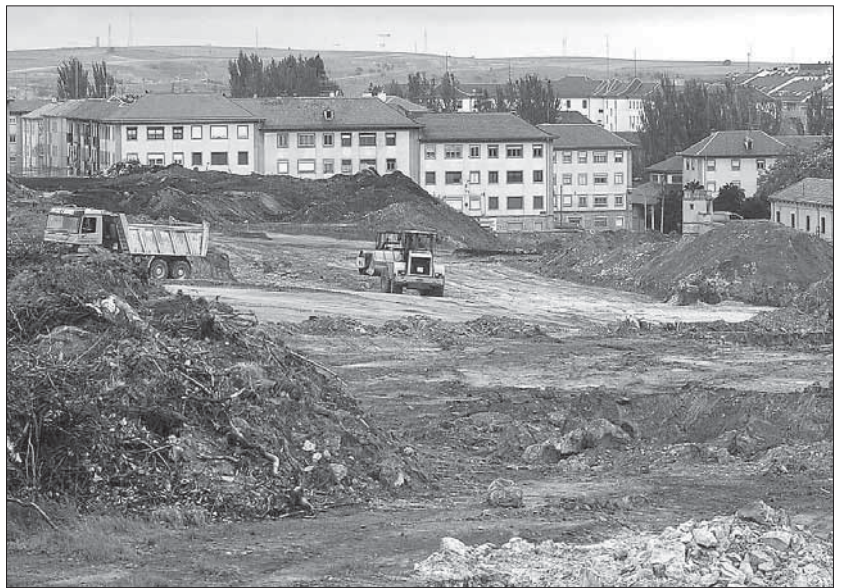
Los trabajos de urbanización del Sector I - Plaza de toros comenzaron en el mes de enero. / JUAN MARTÍN
