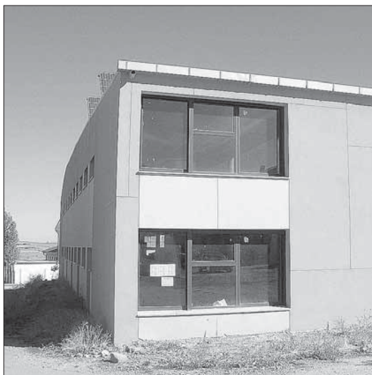
Estado actual del edificio de usos múltiples. /J.H.
