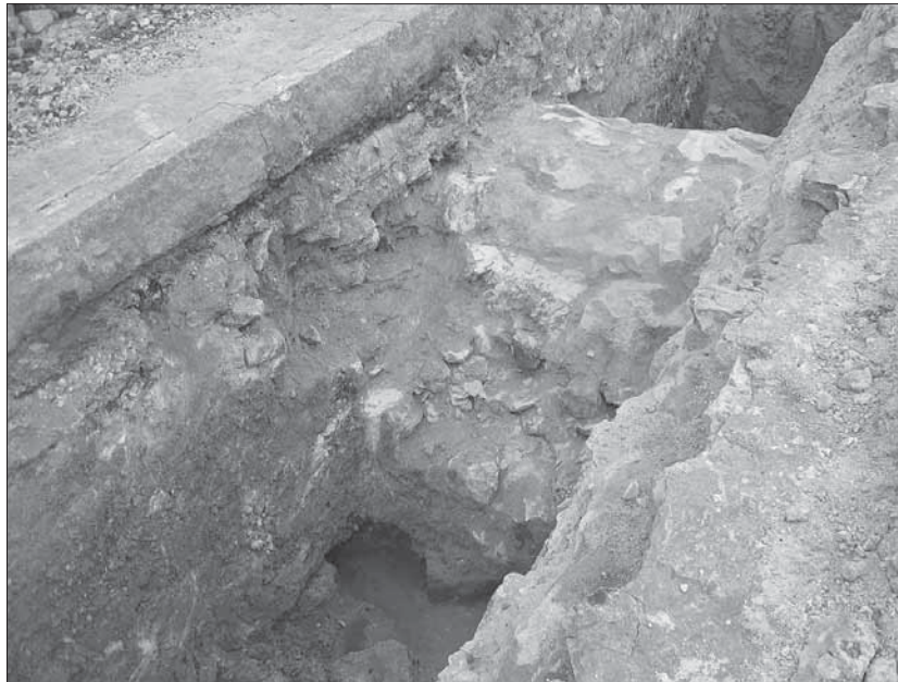
Aspecto exterior del pasadizo que atravesaba la zanja abierta en los trabajos de mejora del saneamiento./EL ADELANTADO
