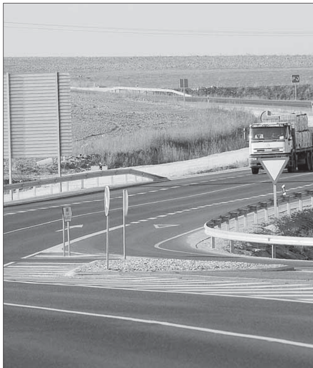
El arreglo del tramo de carretera entre Navalmanzano y el cruce con la carretera CL-603 fue una
