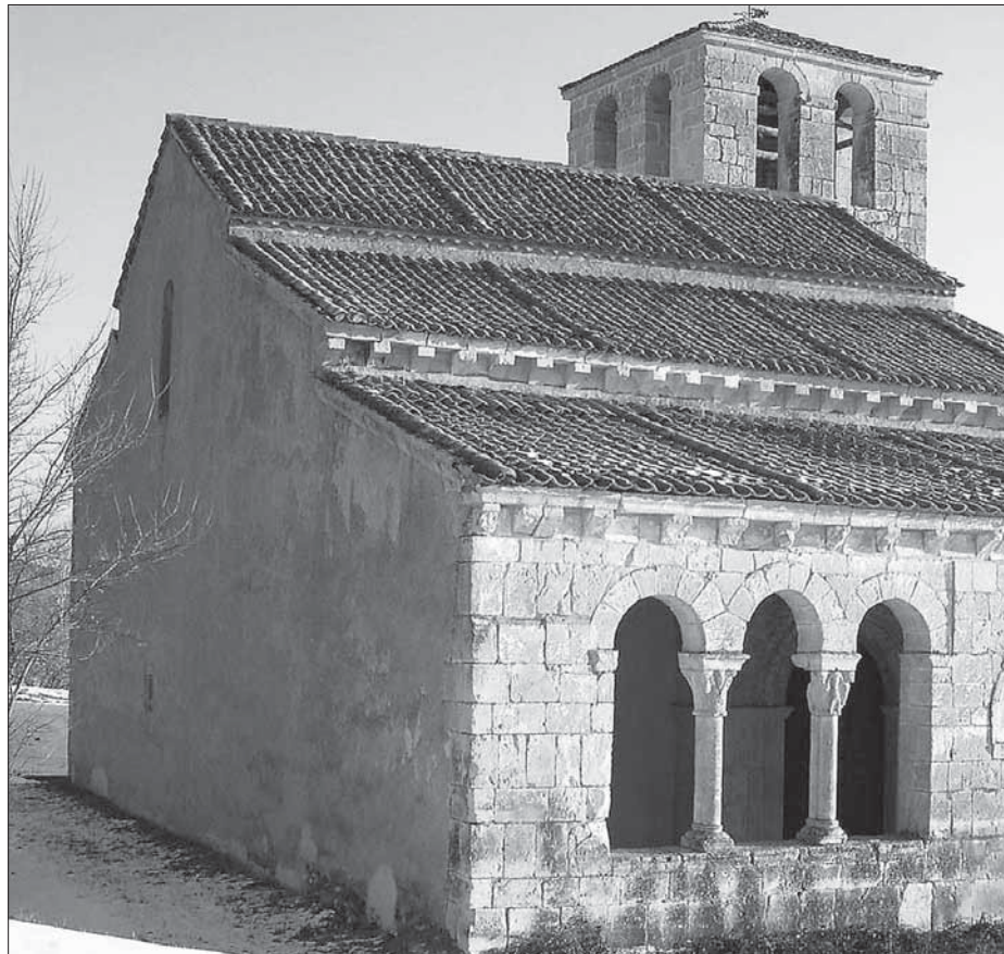
La iglesia de Nuestra Señora de las Vegas, en Requijada, es monumento nacional desde 1969 y dispone de una bella galería porticada en el
