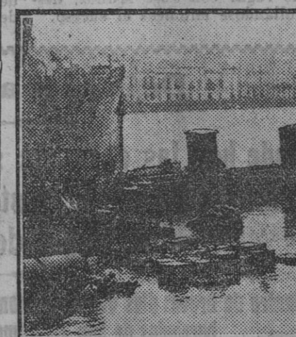
Un aspecto del muelle, invadido por las aguas del Guadalquivir, que han cubierto gran cantidad de mercancías y alcanzan el nivel de las bateas del ferrocarril de la Junta de Obras. Foto. S. del P.
