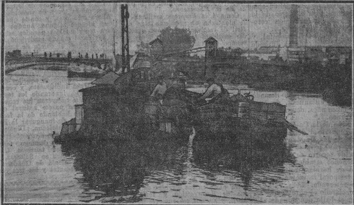
Trabajos de salvamento de las mercancías depositadas en el muelle
