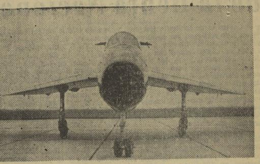
NUEVO MODELO DE AVION. — He aquí el último modelo de avión experimental, ideado por los inventores británicos. Se llama "Short-S. B." y lo impulsa un solo motor. Caracteriza al aparato la extrema pequeñez de sus alas, que permiten ser ajustadas y dispuestas a diversos efectos.
