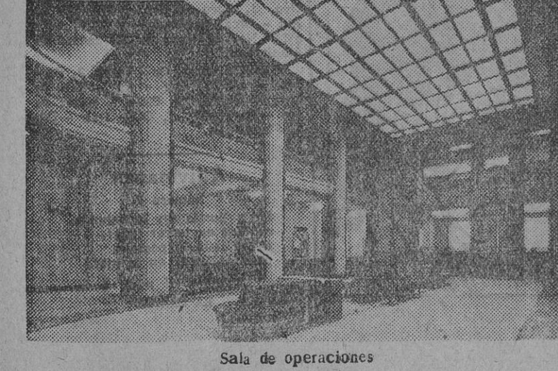
Sala de operaciones
