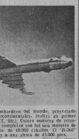
El "Convair B-36", el mayor bombardero del mundo, proyectado para bombardeos estratégicos intercontinentales, realiza su primer vuelo de pruebas en Fort Worth (EE. UU.). Cuatro motores de retropropulsión, montados bajo las alas, completan con los seis motores de pistón la potencia total del aparato, de 40.000 caballos. El "B-36" puede volar a 430 millas p. h. y a una altura de 45.000 pies. (Foto Keystone)
