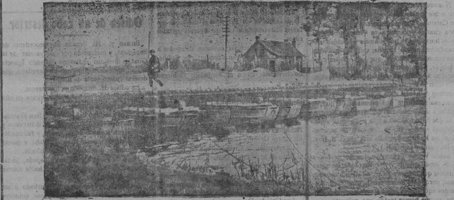
Puente de barcas en el Paso de Calais.—(Kol. Lu.)
