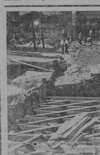
EN LA ESTACION DEL MEDIODIA.—Las obras de reparación de la alcañtarilla que ha producido inundaciones en los almacenes.
