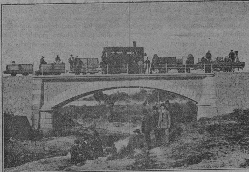
Puente oblicuo de aparejo helicoidal en la confluencia de los torrentes de Esporlas y Buñola
