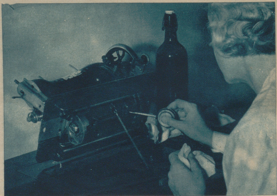
La máquina, abierta, para limpiarla con petróleo
