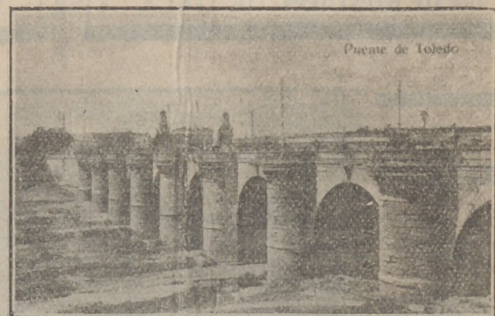
MADRID. — Puente de Toledo
