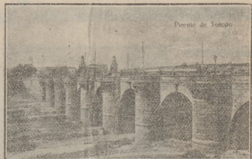
MADRID. — Puente de Toledo
