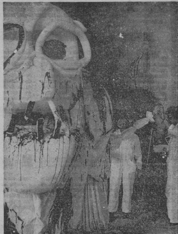
La preparación de la obra
