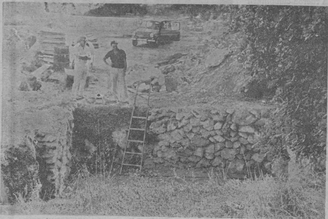
El aljibe que se ha tenido que hacer sobre roca fuerte, para depósito de agua
