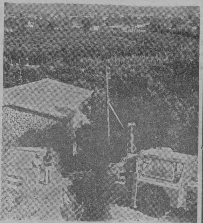
Las obras que se están realizando para que los vecinos de Palmañola puedan tener agua todo el día. En la foto y como primer plano, las obras muy cerca de la «Font Seca». Al fondo se puede ver la urbanización
