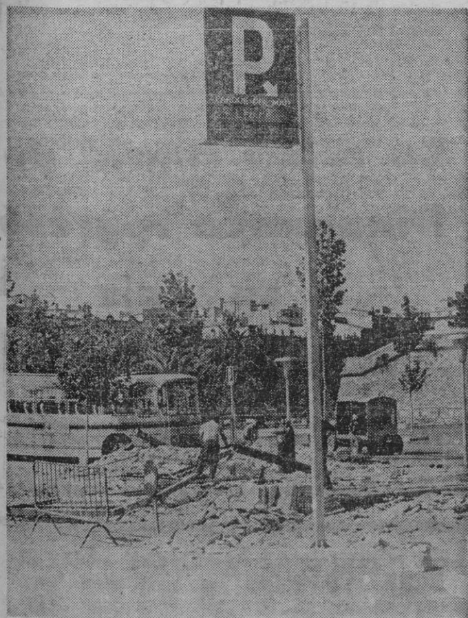
Por fin, en el Parque del Mar, se está procediendo a derribar el tan polémico puente. Desde hace dos días se trabaja en ello.
