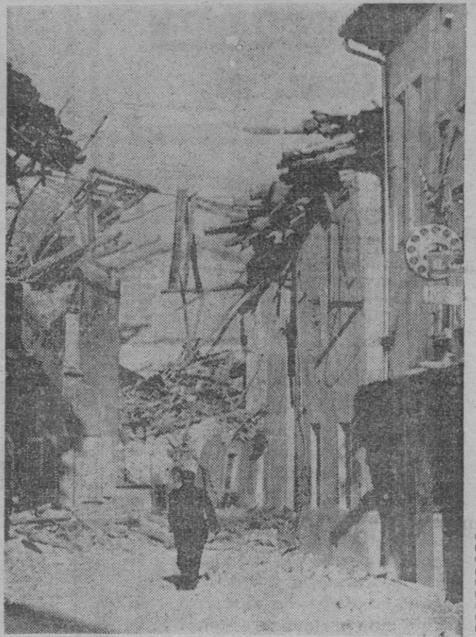
CASAROLA. — En la foto un desolador aspecto de la ciudad tal como está, después del terremoto que ha afectado gravemente a la zona norte de Italia. — (Cifra Upi)
