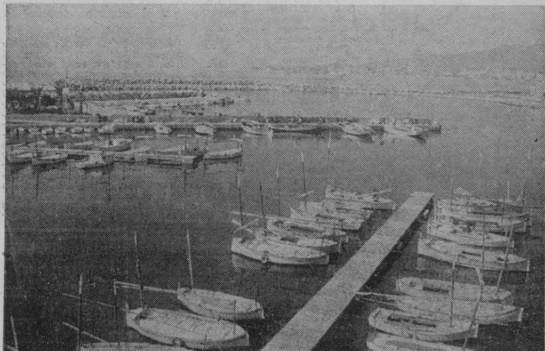
La Junta de Obras del Puerto ha dragado cuatro metros toda la cala del Portixol, un trabajo que «no se ve», pero que tiene una importancia extraordinaria. Antes, ya construyó el dique que ven al fondo.
