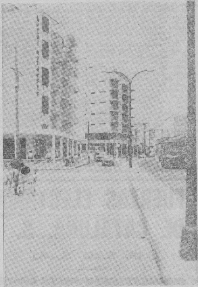
Vista parcial de la avenida principal de Ca'n Picafort. En el centro, se han instalado modernas farolas, que hará posible que, por las noches, aquella zona parezca de día. El ingeniero proyectista es don Feliciano Fuster Jaume y el ingeniero director de la obra, don Francisco Albertí. De esta manera se resuelve uno de los problemas más agudos que tenía planteado el Ayuntamiento de Santa Margarita. Ahora, sería conveniente que se acelerara la desembocadura al mar de las aguas del torrente.
