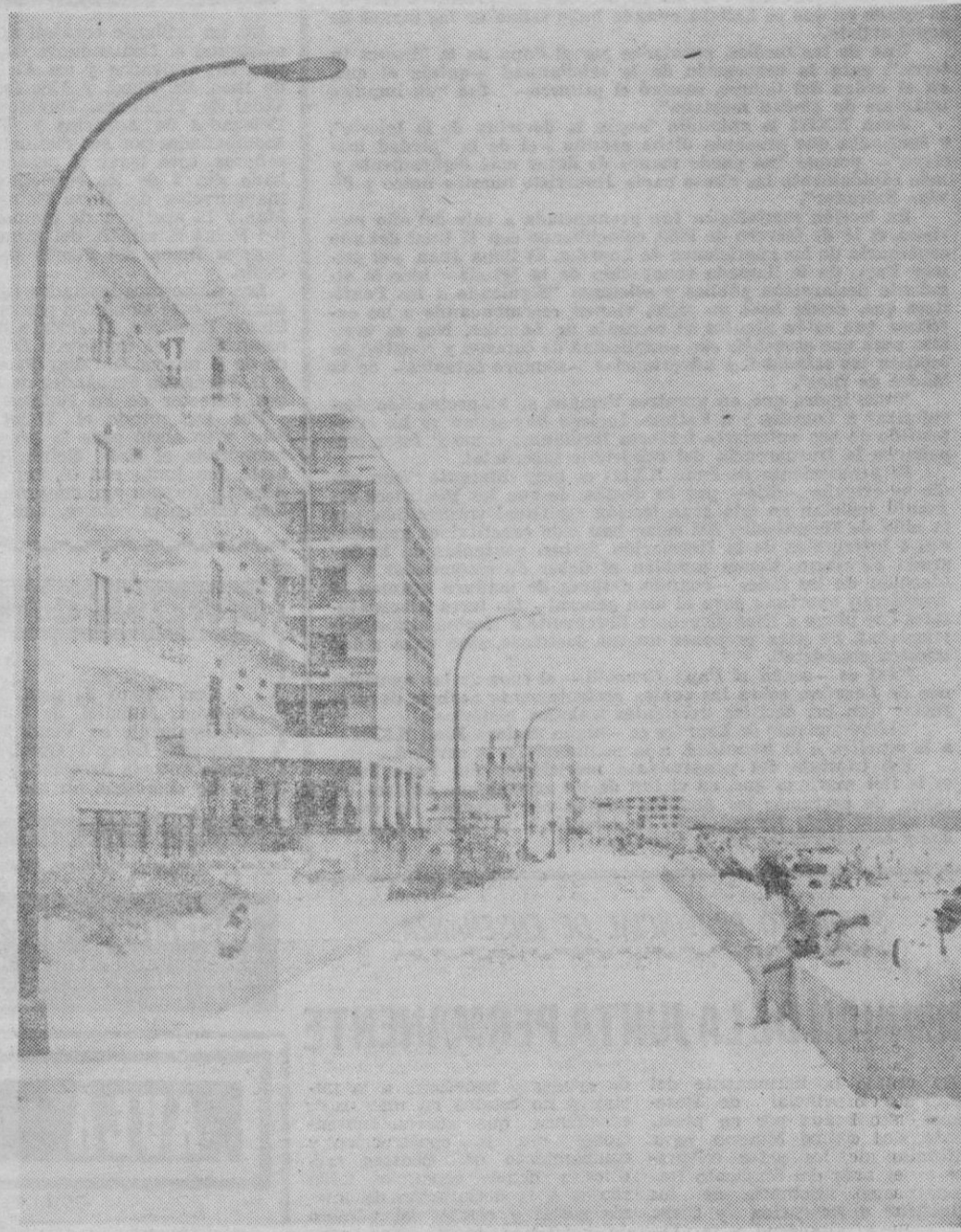
Aspecto del flamante Paseo Marítimo, que ya ha sido terminado. Se han instalado baldosas artísticas, con un muro de contención para el oleaje (derecha), que además sirve de banco para sentarse. A la izquierda, pueden verse también las nuevas farolas.
